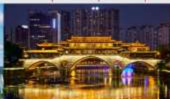
สะพานอันชุน
